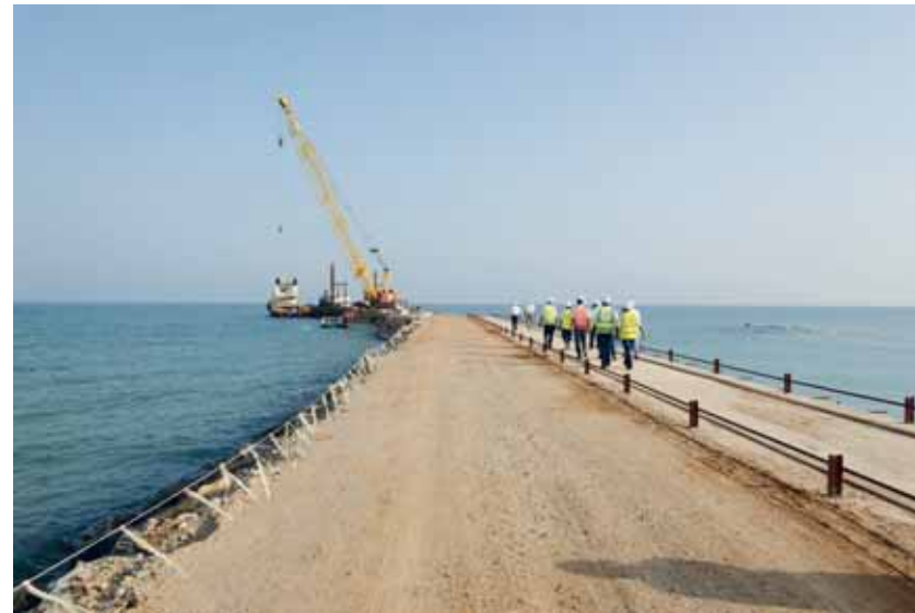
■ من أعمال أحد مشاريع المصبين البحرية التي تقوم «حيا للمياه» بتنفيذها حالياً
