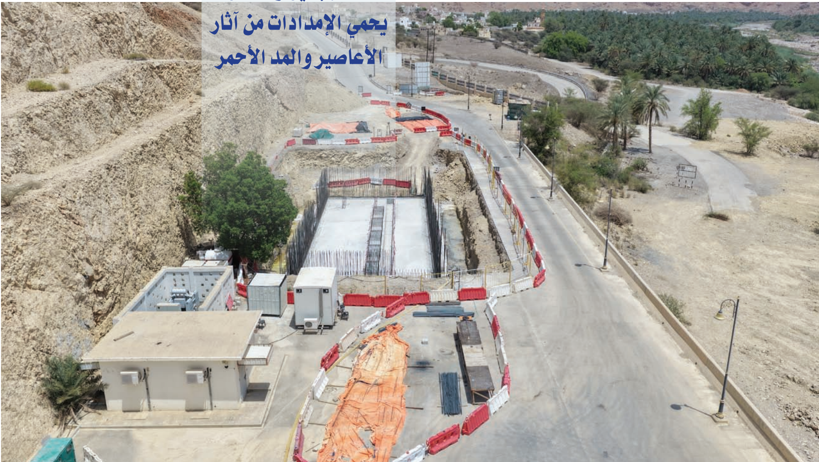
تواصل أعمال إنشاء محطة الضخ المتكاملة مرتبطة بمنظومة التنقية بما يتيح نقل المياه من السد إلى مرافق المعالجة والتخزين
