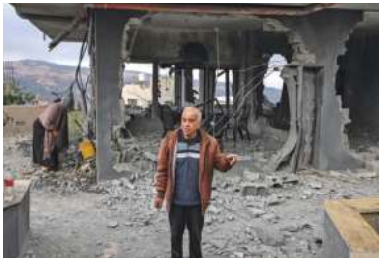
■ والد والدة الشهيد مهدي شحادة يتفقدان الأنقاض في الطابق الأرضي من منزلها بعد عملية دهم قامت بها قوات الاحتلال جنوب غرب نابلس.
