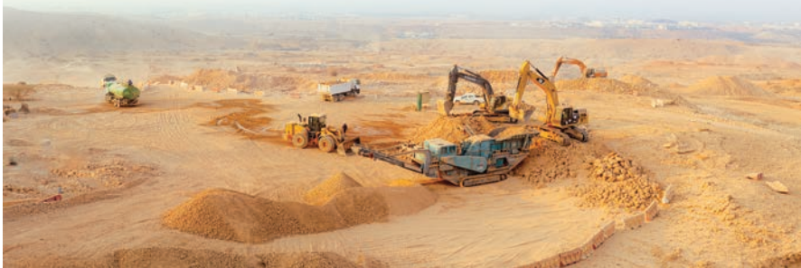
■ أعمال تسوية التربة ونقل الصخور في موقع المشروع
